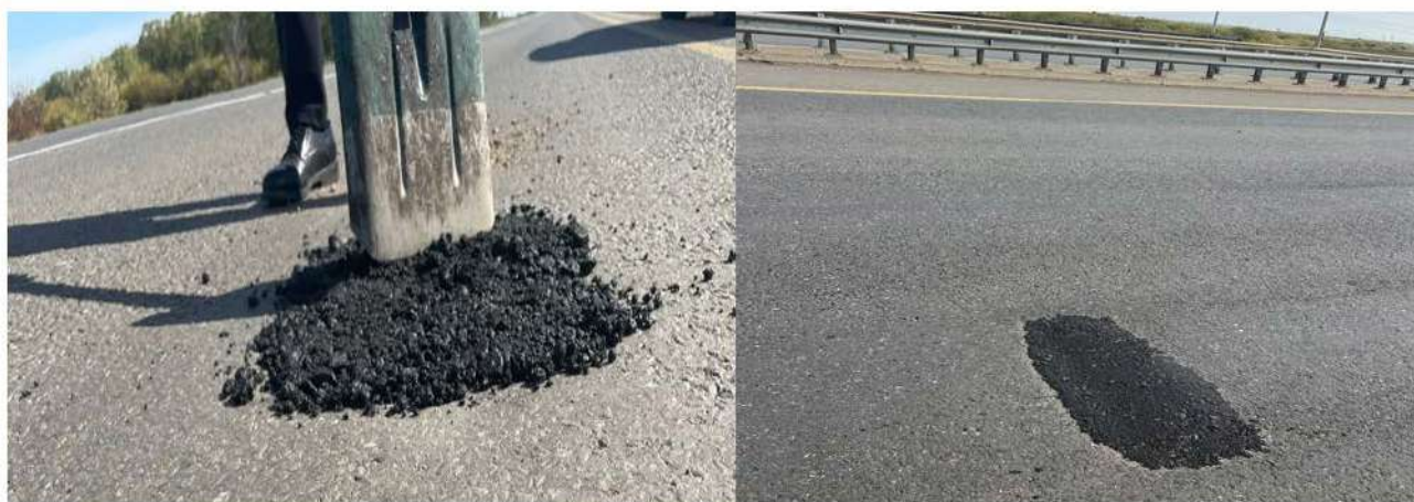
Рис. 9-10. Уплотнение и затвердевание холодной смеси.
