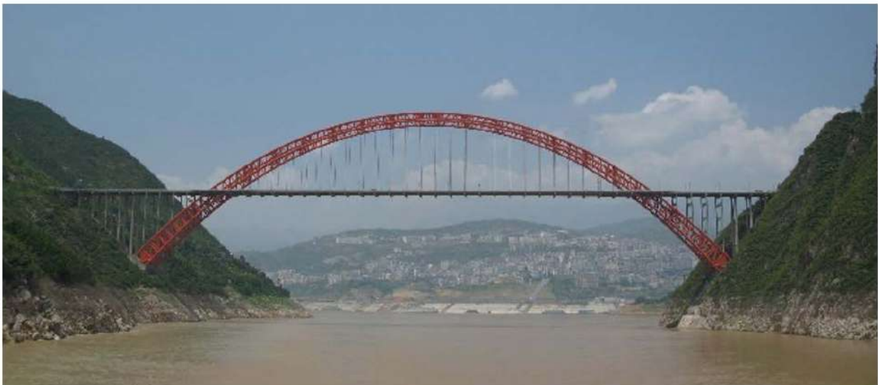
Рис. 2. Трубобетонный арочный мост Chongqing Wushan Bridge.
