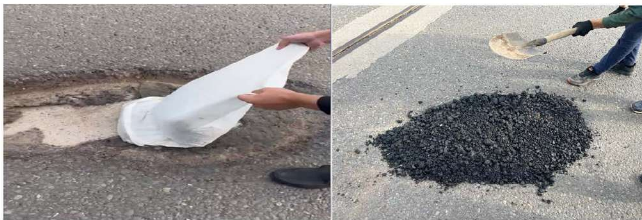
Рис. 7-8. Заделка выбоины с помощью холодного асфальтобетона с добавкой Halik Soup.
